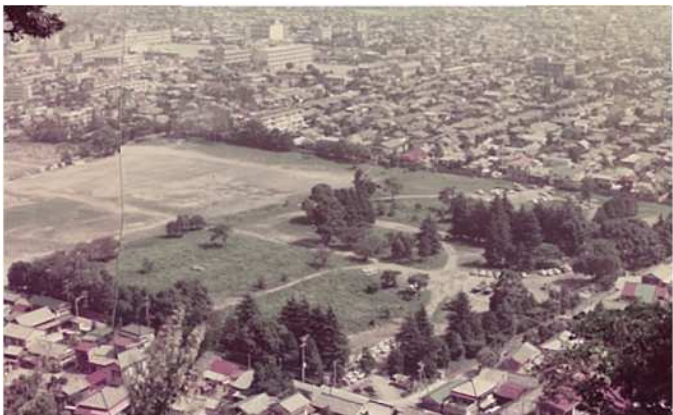
静岡大学解体後の状況
