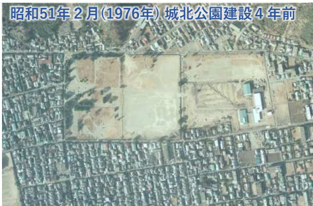
静岡大学解体後の状況（航空写真）
