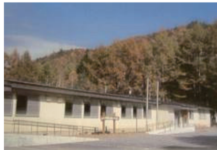
南アルプス自然ふれあいセンター 出典:「静岡市 HP」(静岡市)
