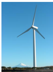
風力発電施設「風電君」
