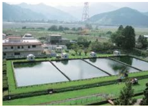
浄水場 (葵区門屋)
