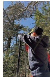
ぼろろくさくせっち 防鹿柵の設置
