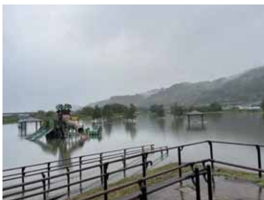
あさはた緑地での雨水貯留の状況
