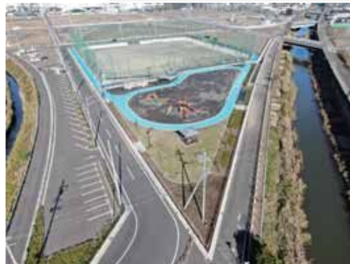
恩田原公園 (雨水貯留機能と一体的に整備した 街区公園の事例)
