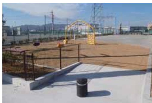
三保陽だまり公園 (静岡市無償借地公園制度による整備事例)
