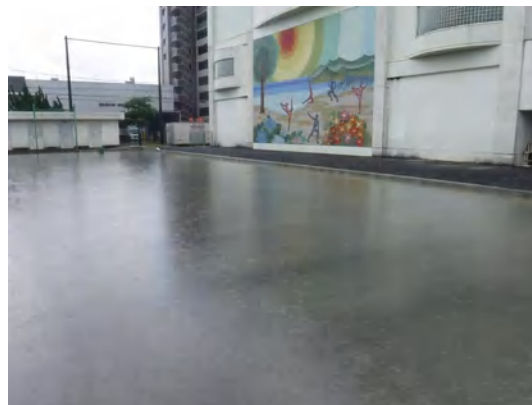
学校のグラウンドでの雨水貯留の状況
