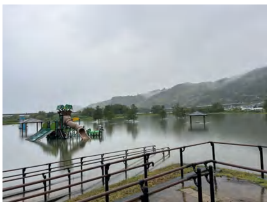
あさはた緑地での雨水貯留の状況
