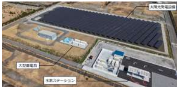
グリーン水素を用いた清水水素ステーション(清水区)
