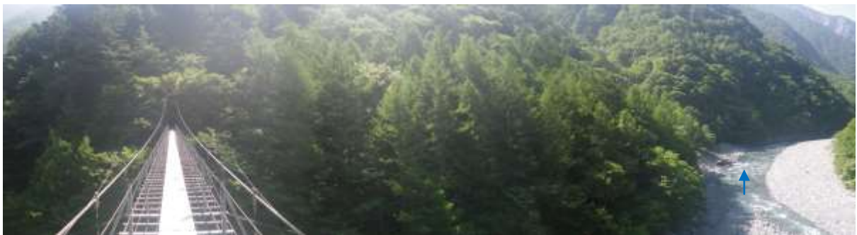
図5-6 地点③ 中ノ宿吊橋から東方面【H・I：発生土置き場】
