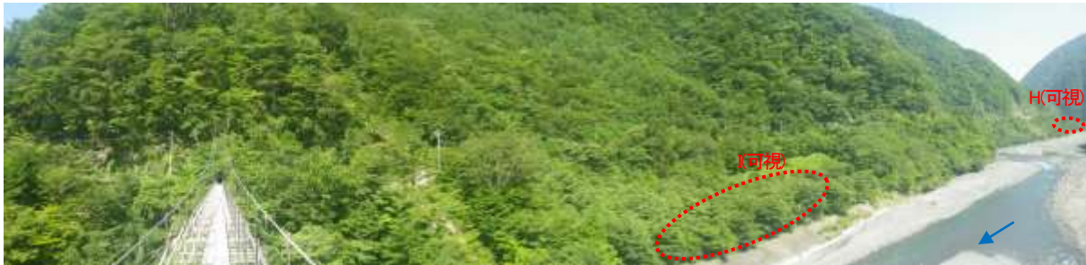
図5-4 地点③ 中ノ宿吊橋から西方面【H・I：発生土置き場】
