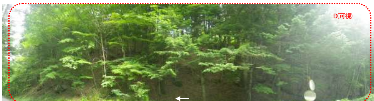
図5-11 地点④-D-4 林道東俣線（24.6km）から東方面【D:工事施工ヤード】
