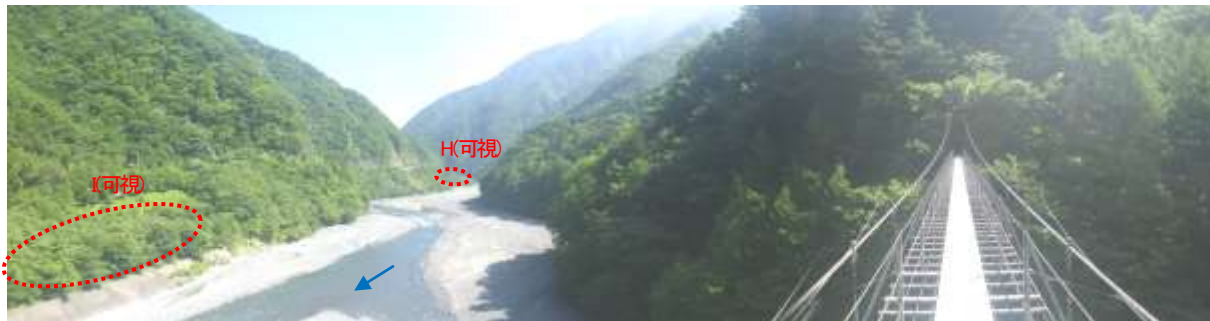
図5-5 地点③ 中ノ宿吊橋から北方面【H・I：発生土置き場】
