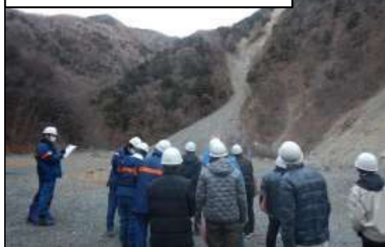
宿舎予定地及び周辺崩壊地
