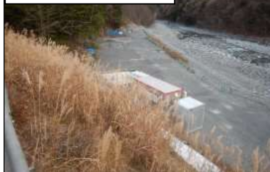
導水路トンネルヤード
