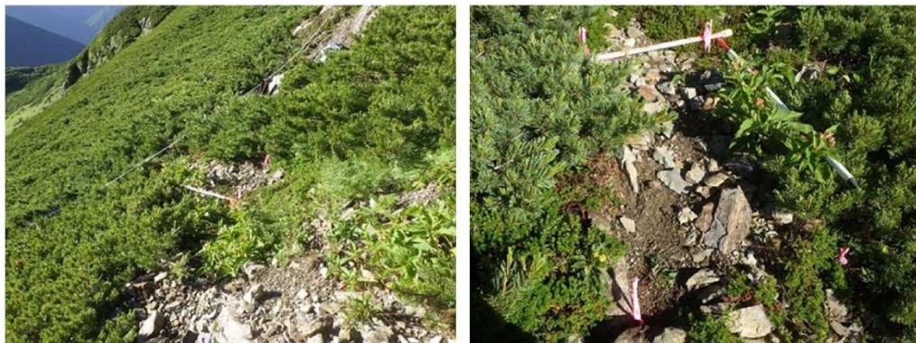
図 31 掘削調査実施箇所の状況（カール部、掘削前）
