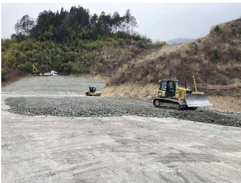
写真 3 他工区における施工状況
