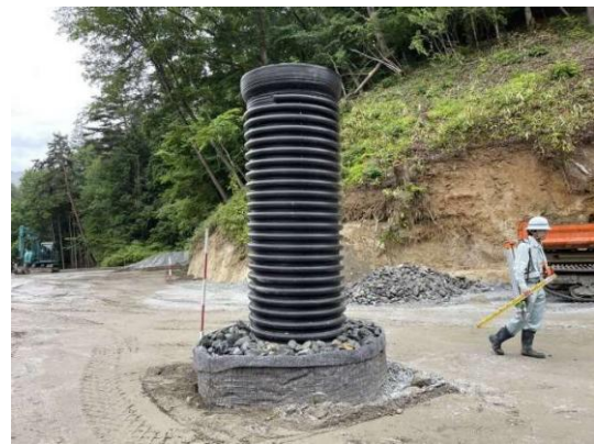
写真 2 水平排水工及び縦排水工の例
