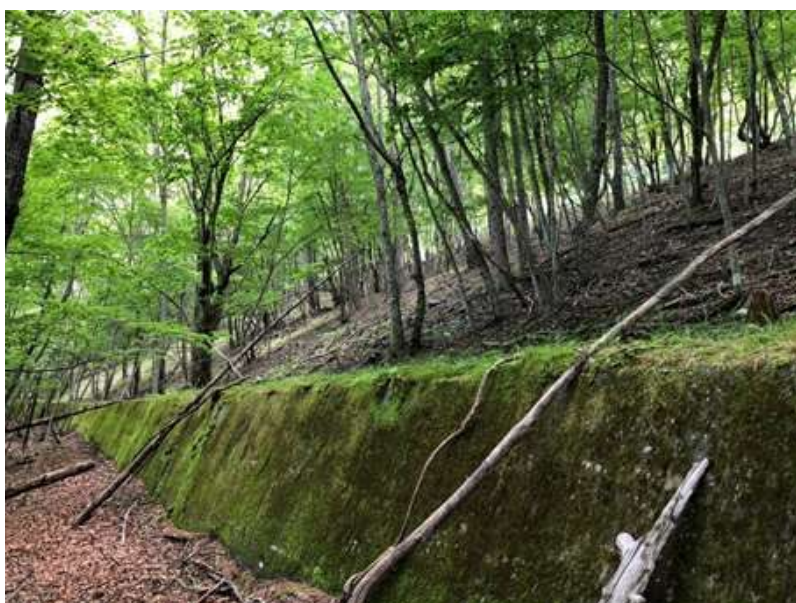
写真 1 藤島発生土置き場現地状況
