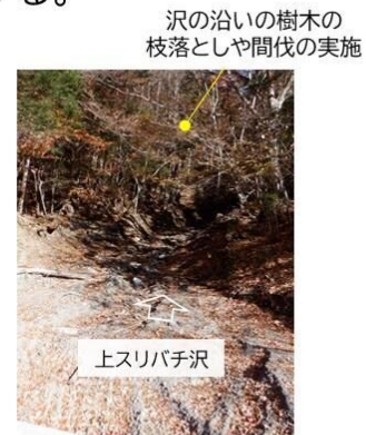
沢の沿いの樹木の枝落としや間伐の実施 林道から仰視した沢の状況
