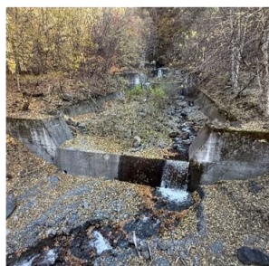
治山ダムの一例
