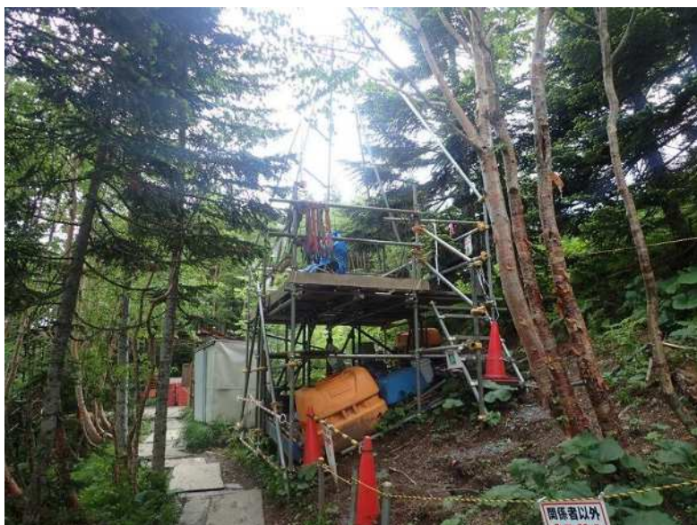
ボーリング調査の実施箇所
