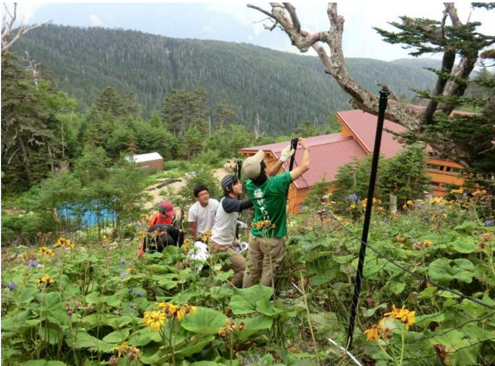
防鹿柵の設置の様子 (千枚小屋付近)
