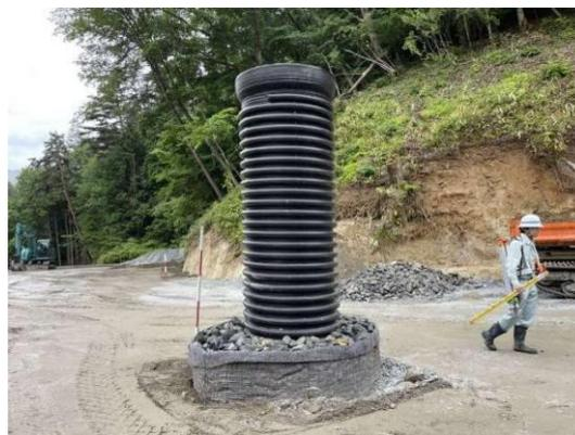
**写真 2 水平排水工及び縦排水工の例**
