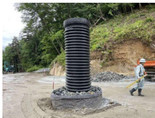
写真 2 水平排水工及び縦排水工の例
