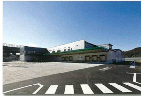
配送回収口外観
