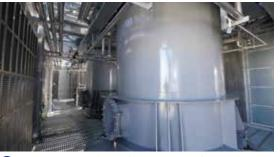
プ炭化物ホッパ(20㎡×2基、28㎡×1基) Carbide hopper (20 ㎡ x 2 units, 28 ㎡ x 1 unit) 下水汚泥炭化燃料(炭化物)を一時貯留します。
