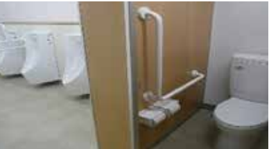
改修後のトイレ
