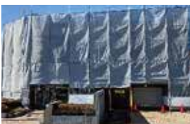
蒲原図書館雨漏り等改修(工事中)
