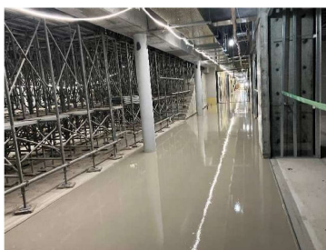
内部廊下の施工状況
