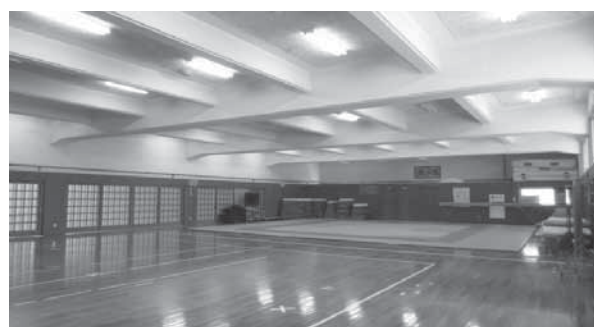
武道場の天井(改修後)
