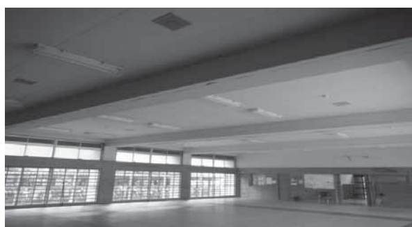
武道場の天井(改修前)
