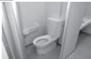
学校施設整備の一例 (トイレリフレッシュ事業)
