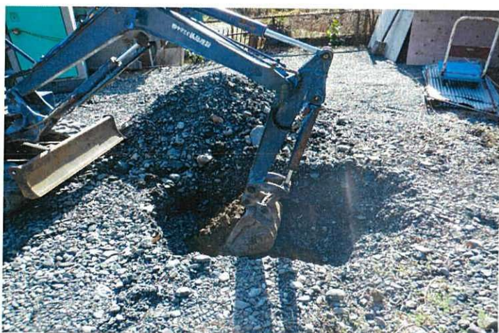
機械による掘削
