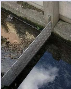
狭い幅員の道路が多い吉川地区では消防車が入れないような場所も多く、火災発生時には消火用水の確保が重要になります。事前に水路に板をはめこめるように工作し、有事の際には板をはめ込むことで水位をあげ、可搬ポンプで水を吸い上げられるように備えています。
