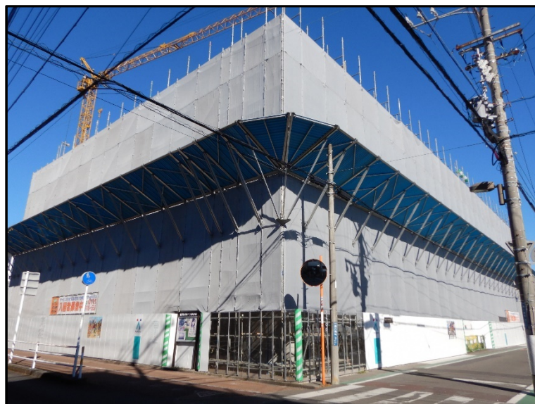
敷地南西（道路側） 写真
