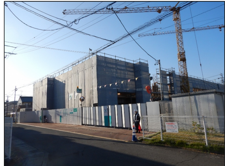
敷地北東（道路側） 写真
