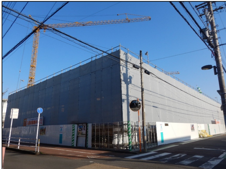
敷地南西（道路側） 写真
