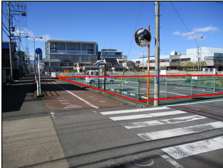
敷地南西（道路側） 写真
