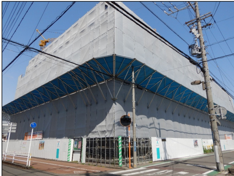
敷地南西（道路側） 写真
