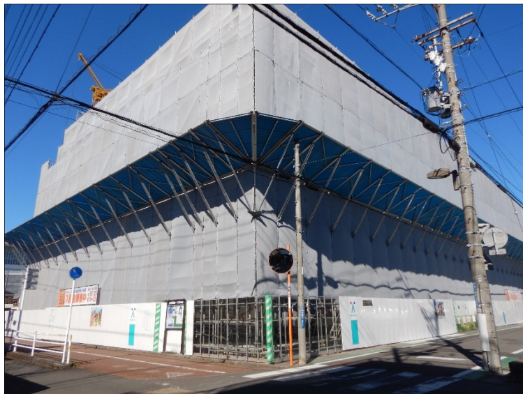
敷地南西（道路側） 写真
