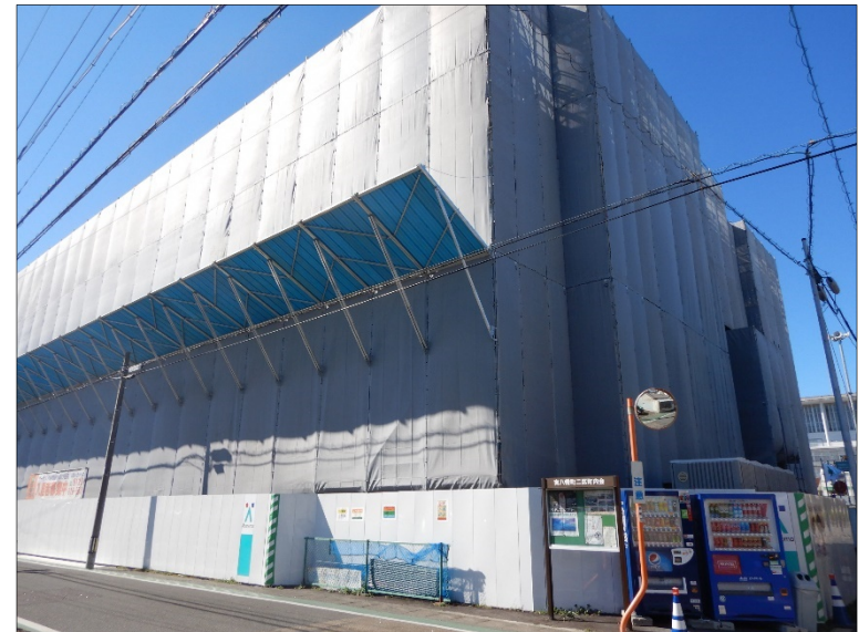
敷地南東（道路側） 写真
