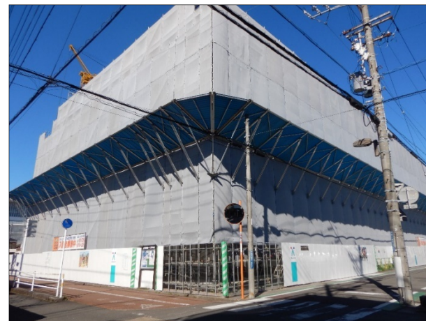
建設中写真（令和3年2月頃）
