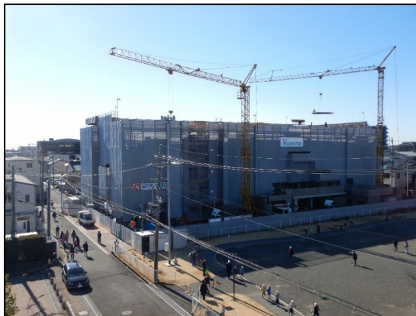
建設中写真（令和3年2月頃）
