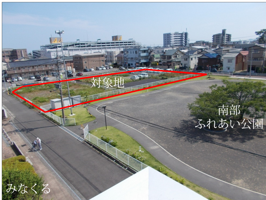
建設前写真（敷地北東側・みなくる屋上より）
