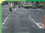
誘導線の設置
