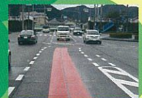
右折車線のカラー舗装
