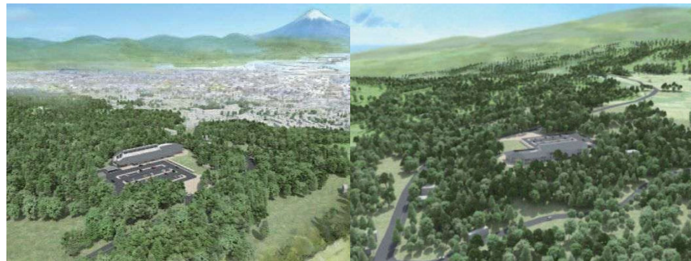
●敷地南からの建物外観
