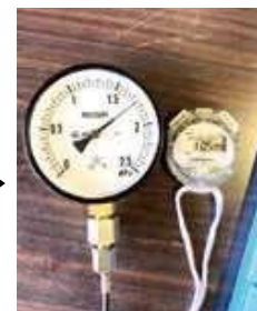
飲料水兼用耐震性貯水槽(応急給水槽)の耐圧試験▶
