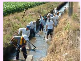
水路の泥上げ
