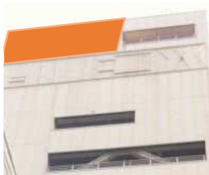
[写真(3):当初設置場所]
