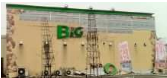
[写真(5):実際にALCと看板が落下している]
