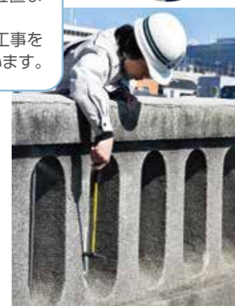
ハンマーを用いた点検
