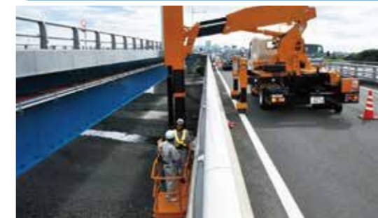
橋梁点検車を利用した点検
