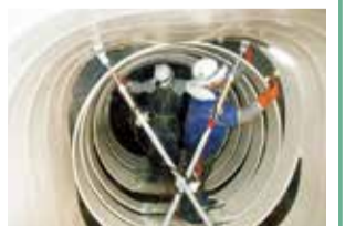
下水道管の耐震工事の様子▲
