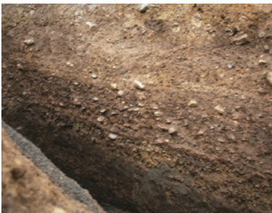
▲地盤改良跡。硬く締め固めた薄い土の層が何層も重なる。
