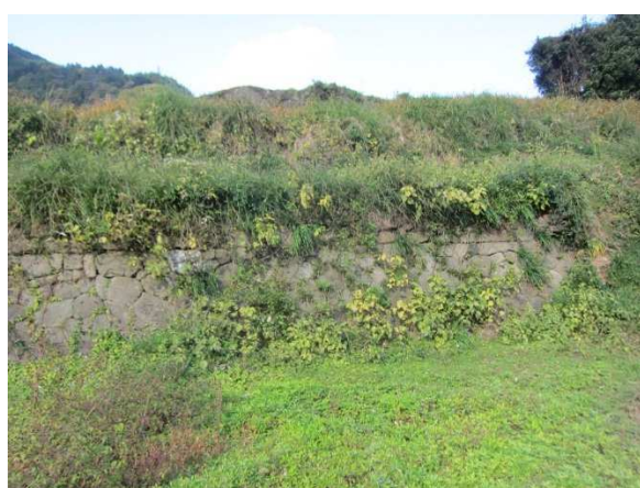
⑤御殿南側下段、下部は B 形式の石垣で、上部は明治以降の積み増しか
