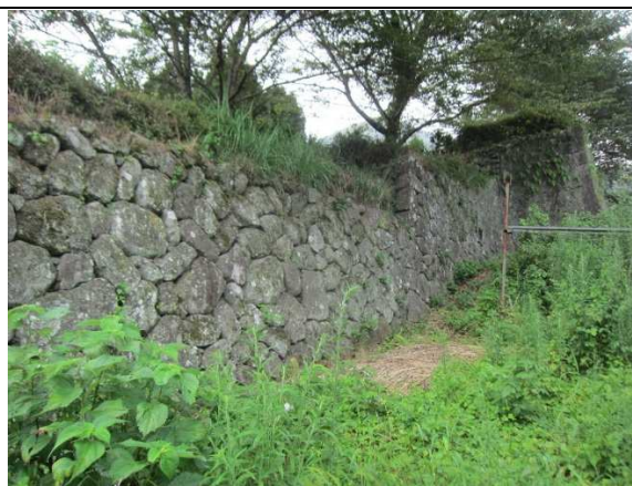
④大手西面の石垣、左手前は C 形式、右奥の出隅は A 形式の石垣
