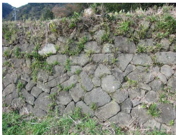
⑩ 主郭北側井戸の北側、下部は安政地震後の積み直し、上部は明治以降の積み増しか
