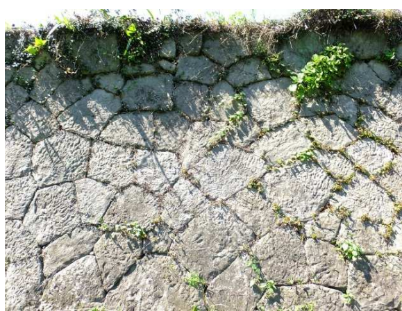
②主郭南西石垣、A 形式の丁寧な切り込み接ぎの石積み
