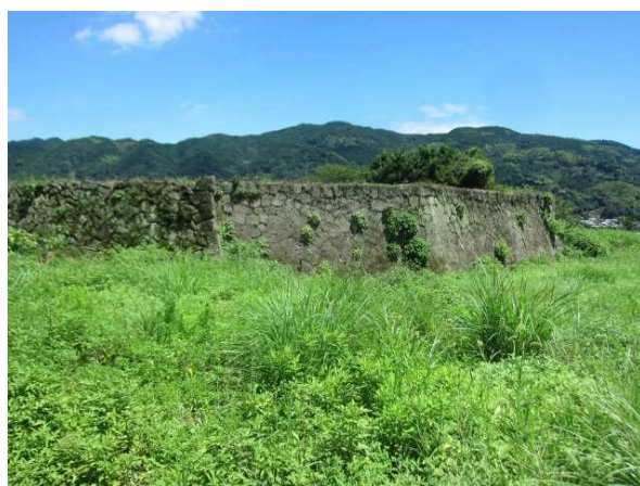
①主郭南西の石垣、A 形式の陣屋造営時の石積み
