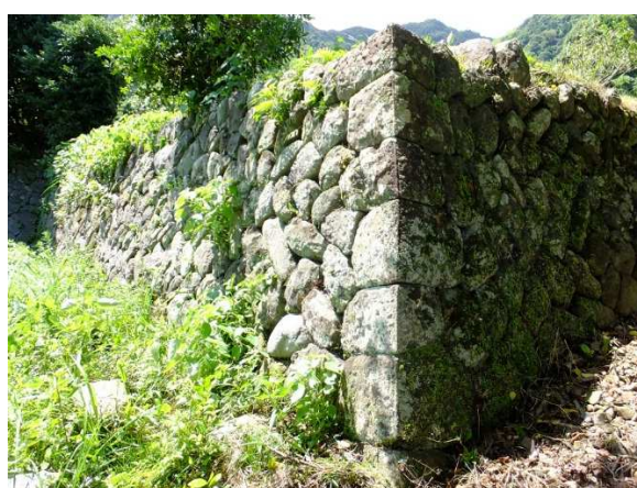
⑥主郭南東の石垣、D 形式の安政地震後の積み直し
