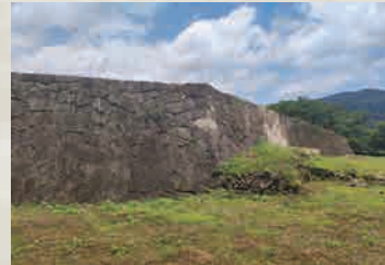
主郭南西部（切込接ぎ・乱積み）
