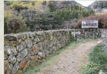
櫓形虎口（打込接ぎ・乱積み）
