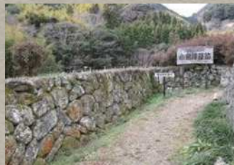
櫓形虎口(打込接ぎ・乱積み)
