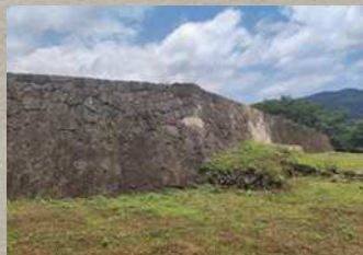
主郭南西部(切込接ぎ・乱積み)
