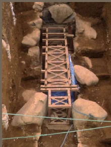
側壁積み直しの様子
