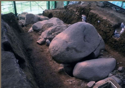
整備時の盛土解体、天井石積み直しの様子
