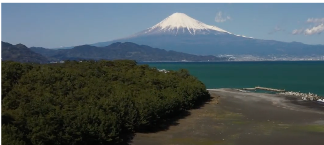
景観改善のための、消波ブロック（1号消波堤、手前）から突堤（1号新堤、奥）への置き換え
