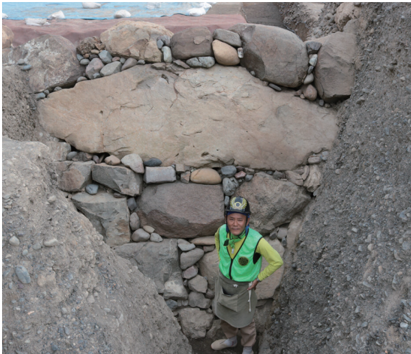
写真5 天守台北面石垣
