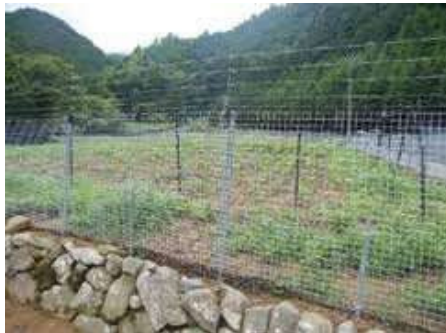
防護柵の設置事例（物理柵＋電気柵）
