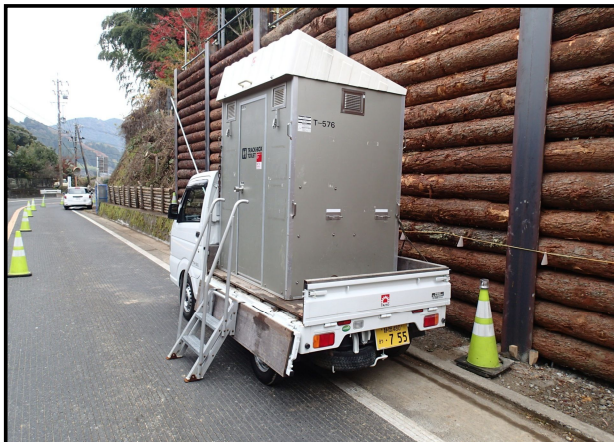
移動式トイレ設置
