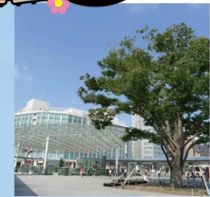
静岡駅北口駅前広場はH20.9完成
