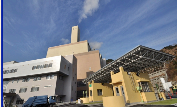
清掃工場の建設（西ケ谷清掃工場）
