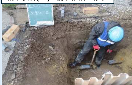
配水枝管(VP)の漏水修繕の様子
