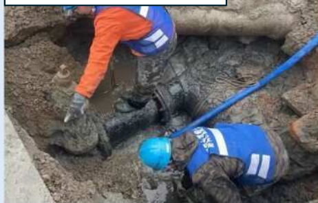
配水枝管(VP)の漏水修繕の様子
