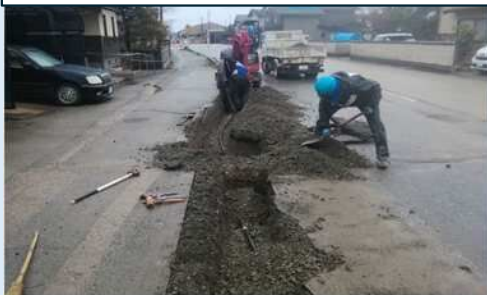
配水枝管(鋳鉄)の漏水修繕
