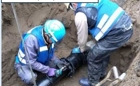
配水枝管(鋳鉄)の漏水修繕
