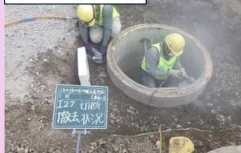
躯体の切断(高さ調整)
