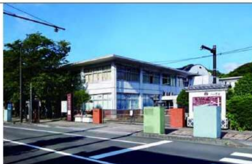
東側道路からみた敷地
