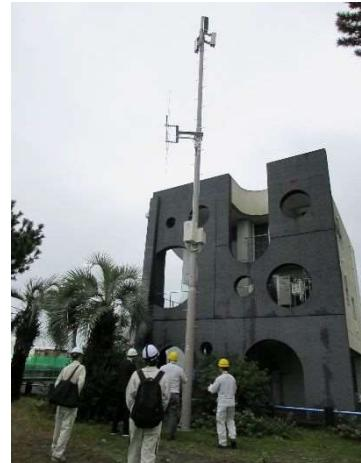
子局のうち「駿 143 広野東公園」(支柱第 1 柱建柱後) 及び「駿 009 用宗公園」(完成) を視察したが、建柱状況、機器取付け・配管状況はいずれも良好であることを確認した。
