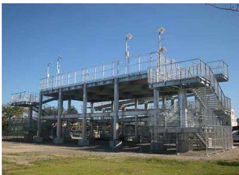
図 5-4 津波避難タワー（長田南 4）
